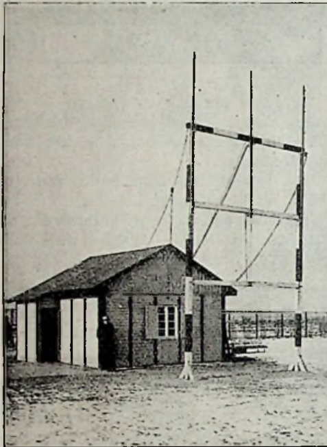
Fig. 2. Richtantenne (C. Lorenz A.G.) met drie loodrechte dipolen, elk een halve golflengte hoog
